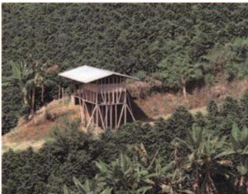
Palafito de ladera; construcción y estructura de guadua con tejas metálicas. Posee una tolva de lámina de guadua para la recolección del grano. Hacienda La Ermita, Palestina, Caldas. Fuente: Villegas, 1989, p. 139.
